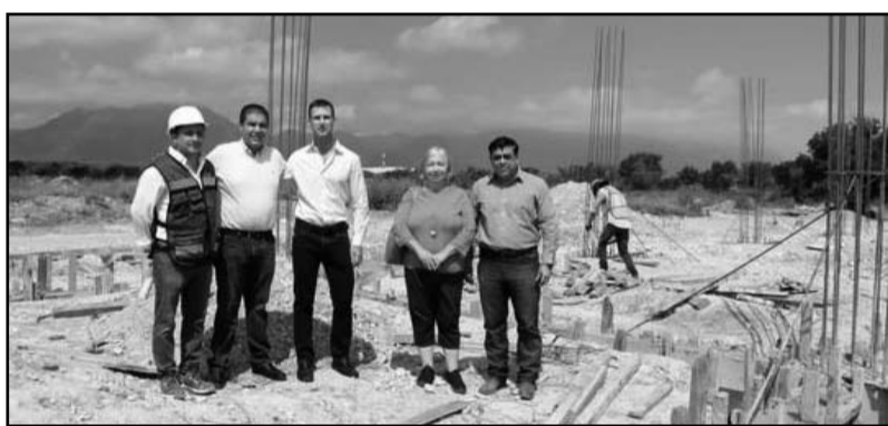
Se construyen varias facultades de la Máxima Casa de Estudios.
