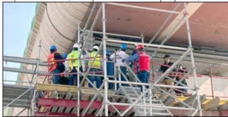
Falta por reconstruir el tramo de Universidad a Sendero.
