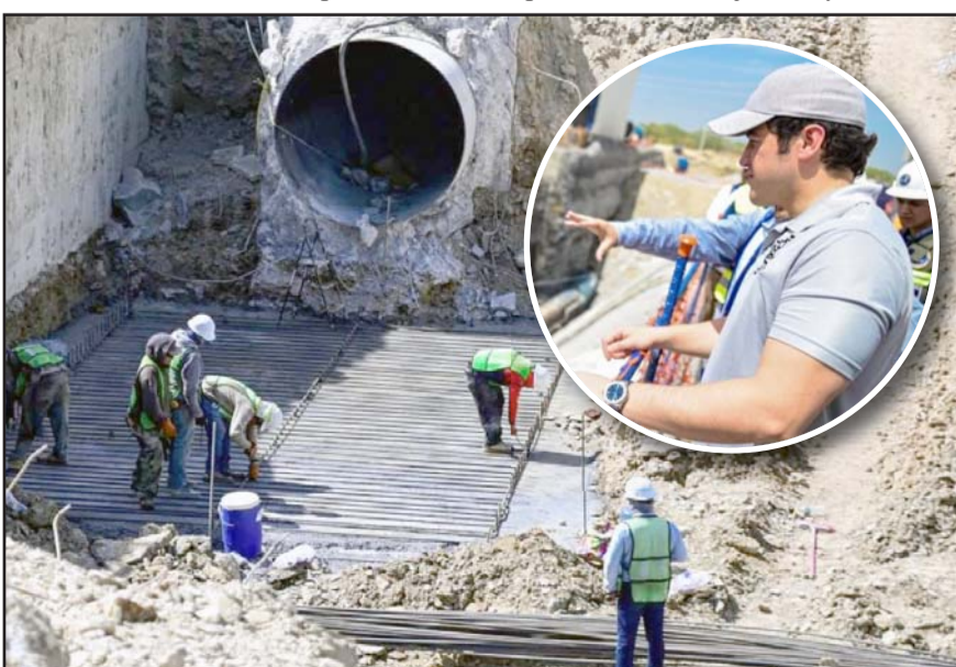
A una semana de que entre en operaciones, ya está casi todo listo, por lo que solo se están haciendo supervisiones de las obras.
