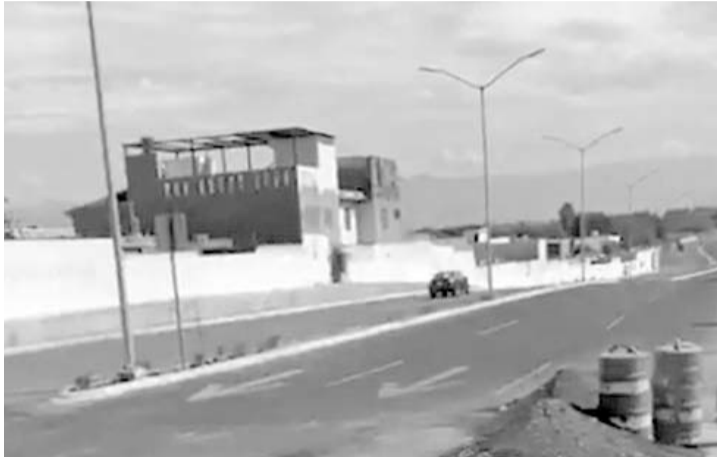
Se trabaja en los últimos detalles del boulevard.
