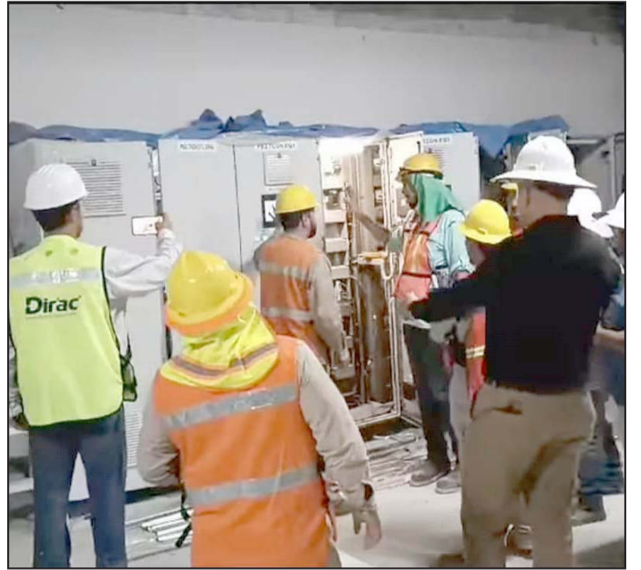
Confirmó que la obra está completamente terminada.
