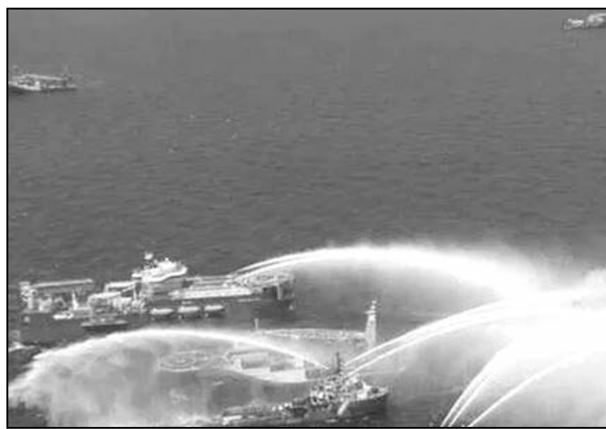
El pasado 7 de julio se presentó un incendio en la Plataforma de Enlace Nohoch-Alfa.
