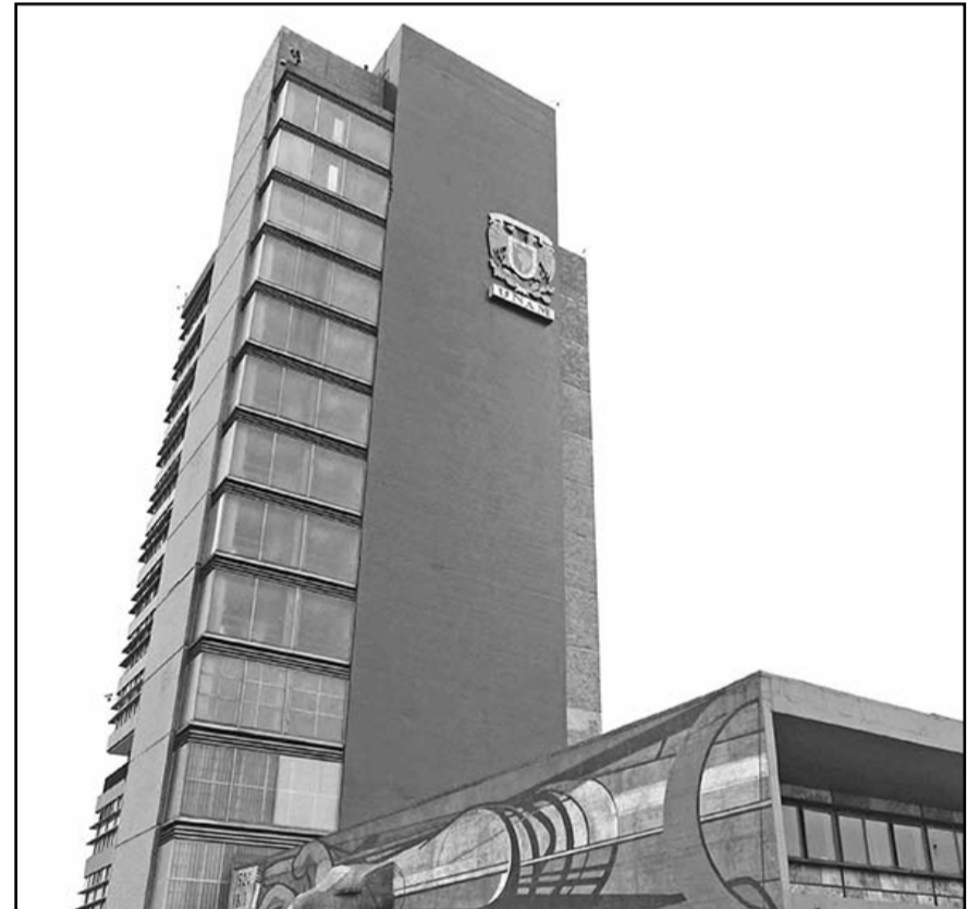
Este miércoles, los integrantes de la junta permanecieron toda la mañana y tarde en sus oficinas del cuarto piso de Rectoría.
