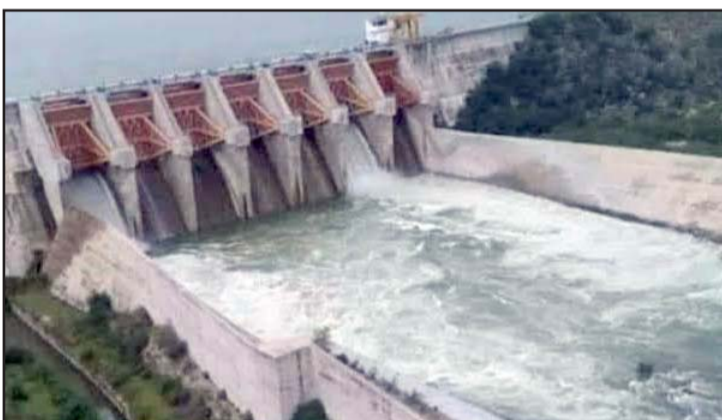
Durante quince días el acueducto parará operaciones.
