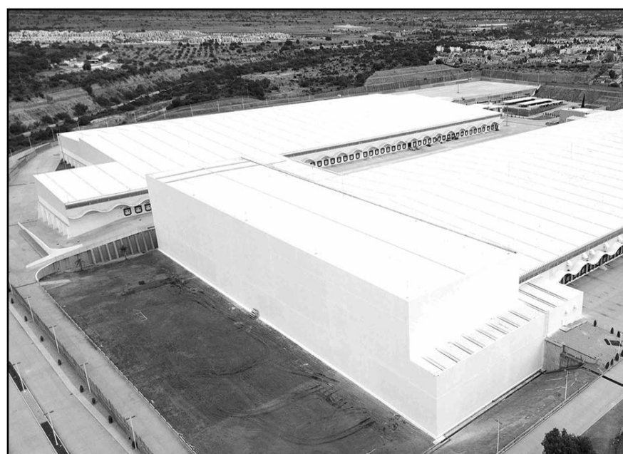
López Obrador aseguró que la megafarmacia de Huehuetoca, Estado de México, contará con medicinas y entrará en operación este mismo día.
