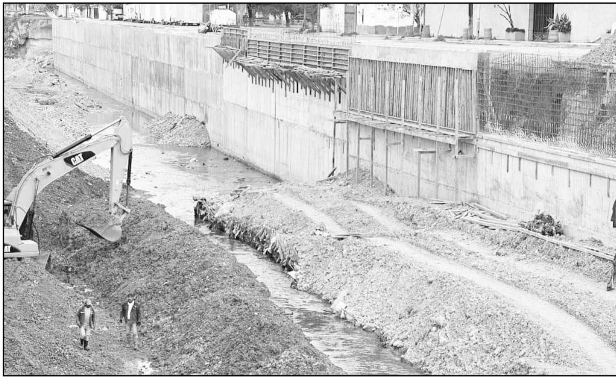
El alcalde de San Nicolás, Daniel Carrillo, dio los permisos del avance de la obra.
