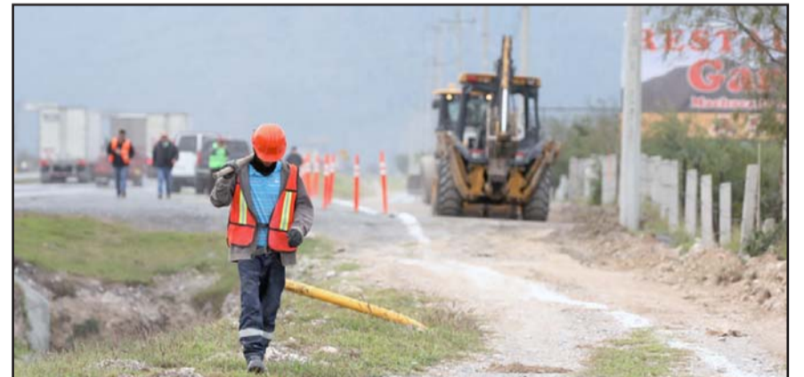
En breve quedarán listas las obras de acceso.
