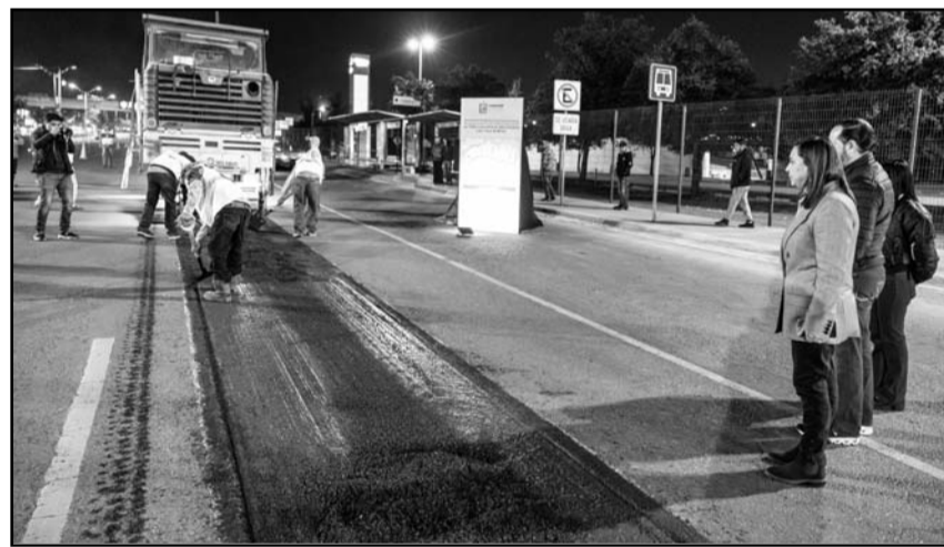
La alcaldesa de Guadalupe, Cristina Díaz, supervisó la obra.
