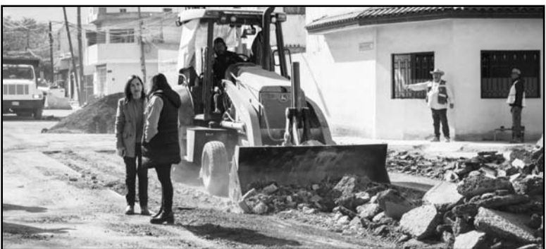
La alcaldesa Cristina Díaz supervisó los trabajos.
