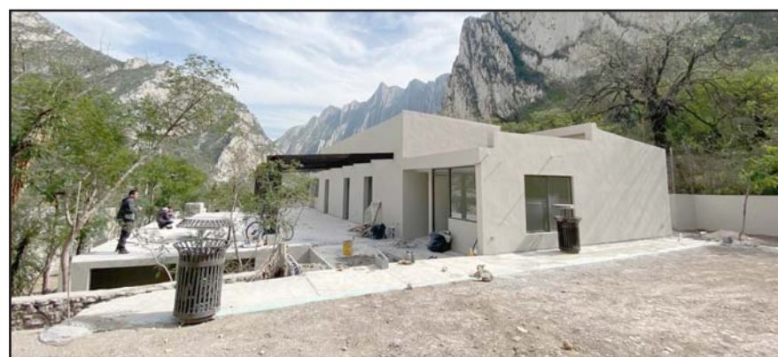
Se siguen construyendo diversas áreas al interior del parque.
