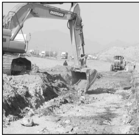
Se llevan acabo las excavaciones.
