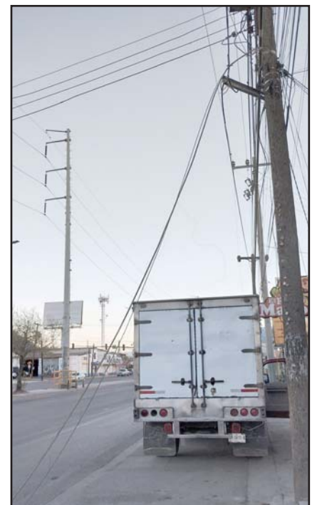
Algunos sectores se quedaron sin luz.
