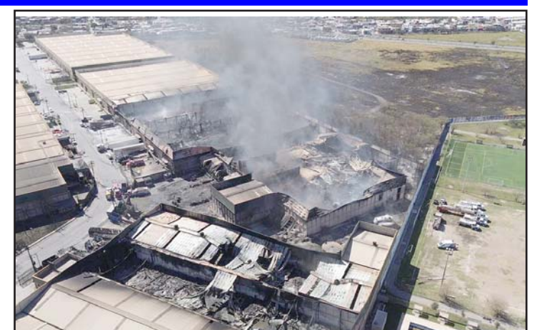
Los daños fueron millonarios en el lugar.
