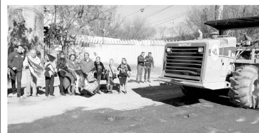
Se utilizará asfalto reciclado.
