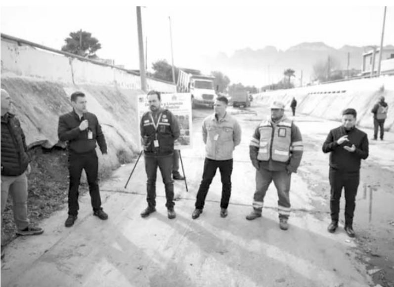
El alcalde Luis Donaldo Colosio supervisó el avance de los trabajos.
