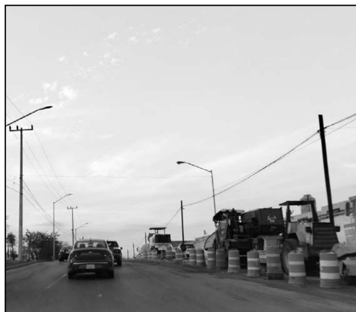
Los trabajos de realizan a lo largo de tres kilómetros
