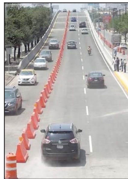
Es temporal a causa de varias obras.
