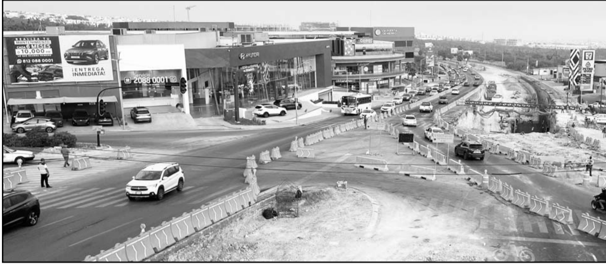
Esto es por el avance de las obras del paso a desnivel en Paseo de los Leones y Puerta de Hierro.
