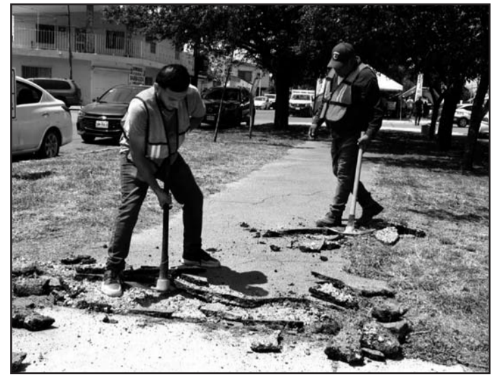
Se rehabilitará un andador peatonal de la colonia
