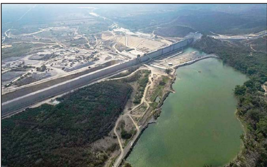
La Presa Libertad y El Acueducto El Cuchillo, de Nuevo León, entre las obras ejecutadas este sexenio en materia hidráulica.
