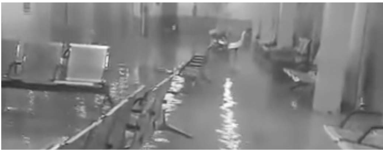
Todos los consultorios, salas, oficinas administrativas y laboratorios quedaron bajo el agua
