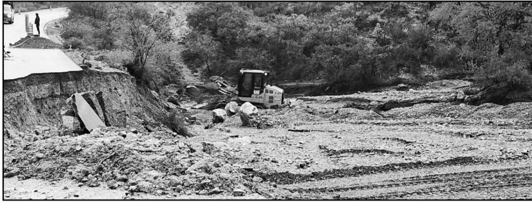
Se utilizó maquinaria pesada como una retroexcavadora y camiones de volteo.
