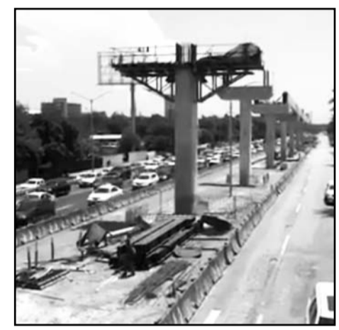
El gobernador supervisó los trabajos que se realizan en el sector.
