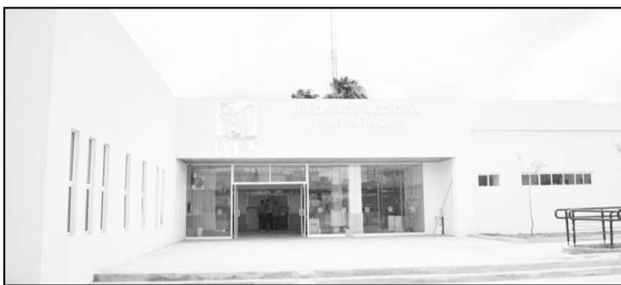
Estaría iniciando en operaciones en el tercer trimestre del año,
