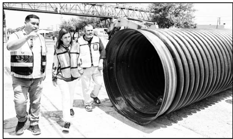
La alcaldesa de Guadalupe supervisó la introducción de drenaje.
