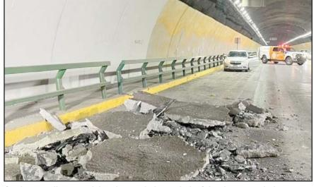
Se desprendio parte del techo por la humedad y falta de mantenimiento
