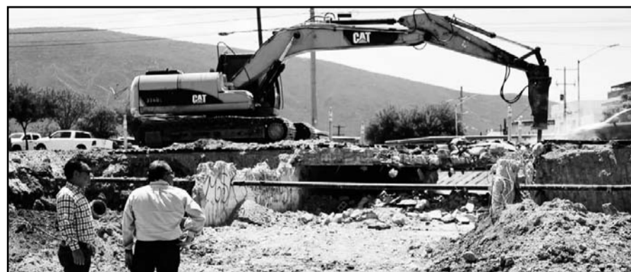
La obra de ampliación registra un avance del 40 por ciento.
