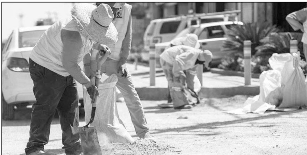
Trabajadores municipales se dieron a la tarea de realizar trabajos de limpieza y rehabilitación de calles.
