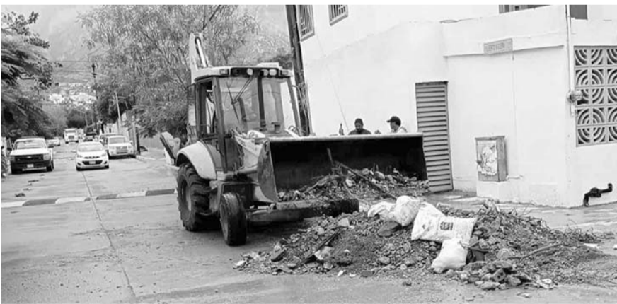
En total recogieron 14.5 toneladas de escombros y basura
