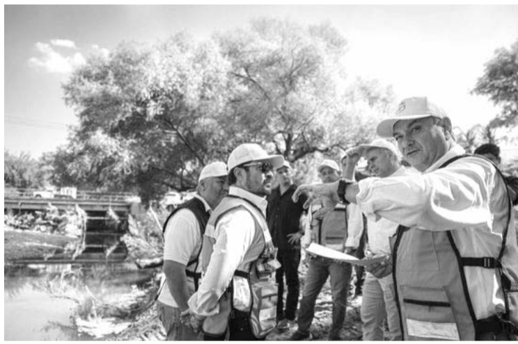
El alcalde de Guadalupe, Héctor García García, arrancó los trabajos de desazolve
