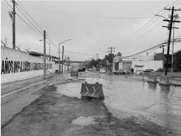
Este tramo presenta severos daños
