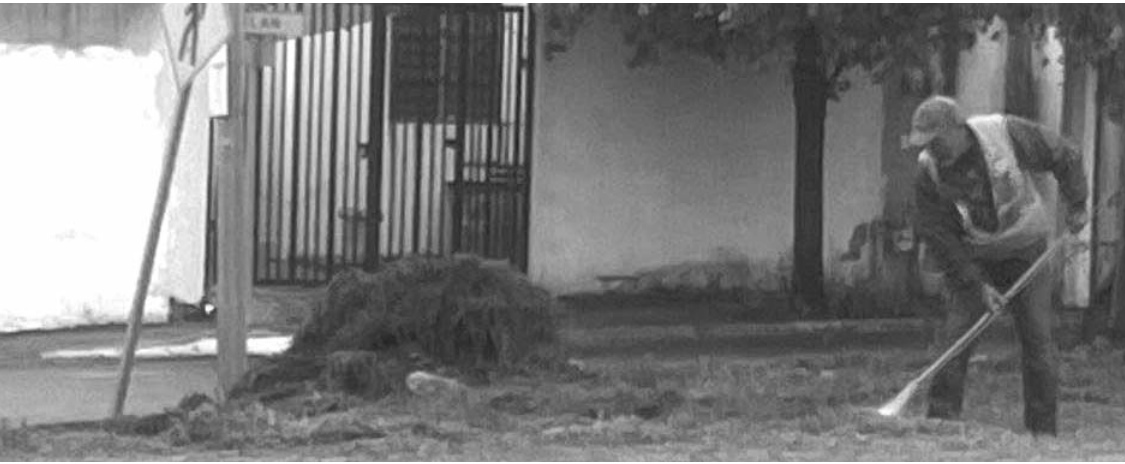
Realizan trabajos de limpieza
