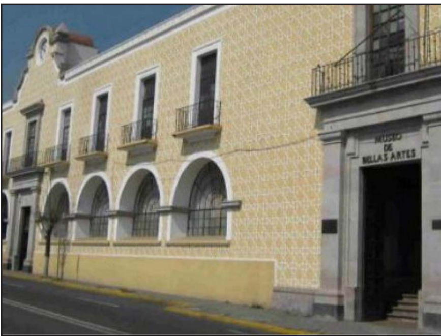
Este museo está ubicado en el ex Convento de los Carmelitas Descalzos.
