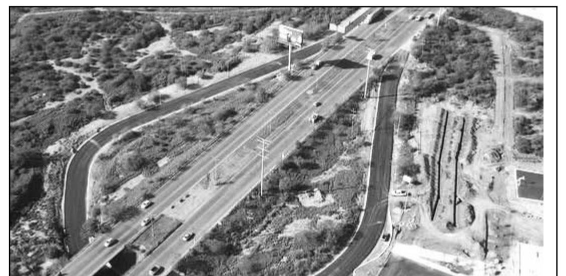
Hasta el momento se lleva un importante avance en las obras que se realizan.
