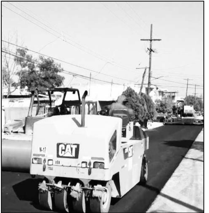
Los trabajos se hicieron sobre la avenida Cerro Prieto
