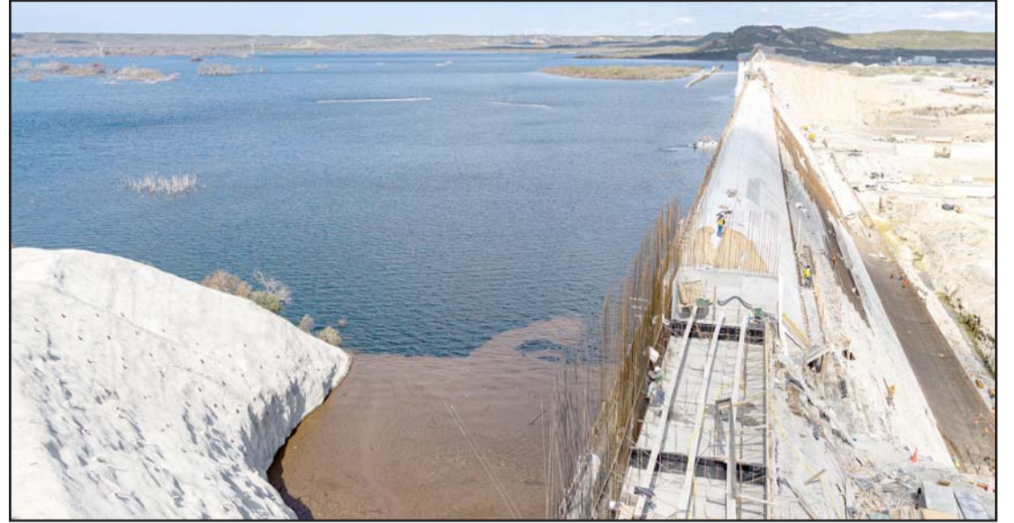
Ayer se dio por terminada la construcción de la cortina de la presa ubicada en Linares.
