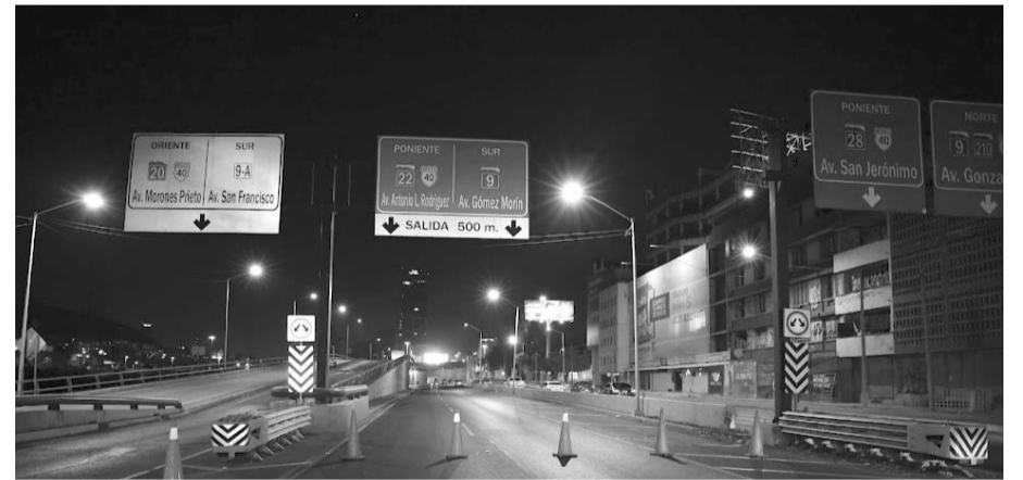
Las primeras labores se concentraron sobre el puente Gonzalitos
